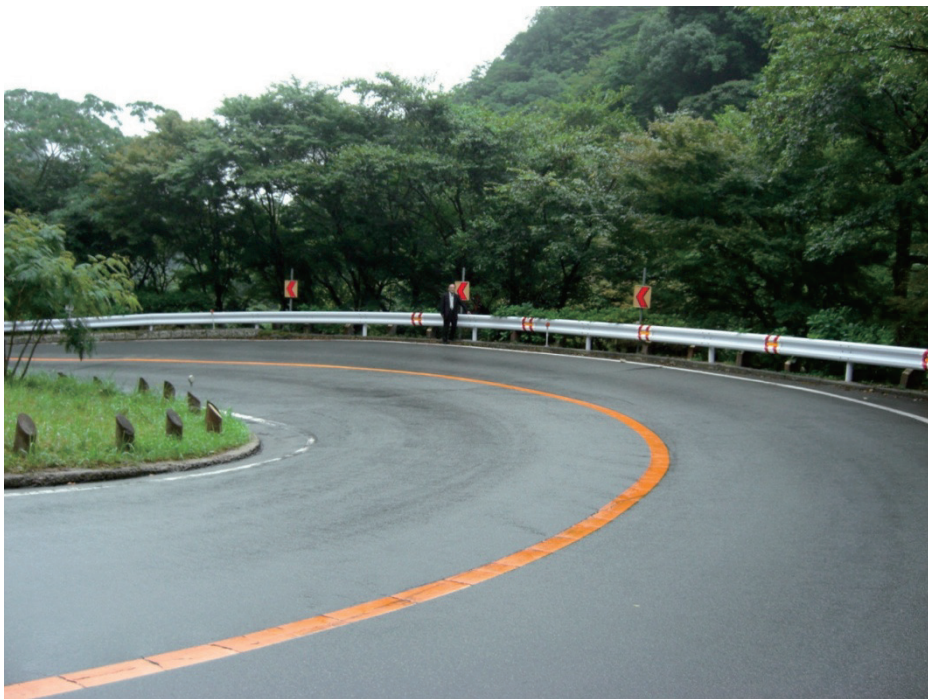
2) 事故発生場所：立ち位置が縁石への衝突点付近
