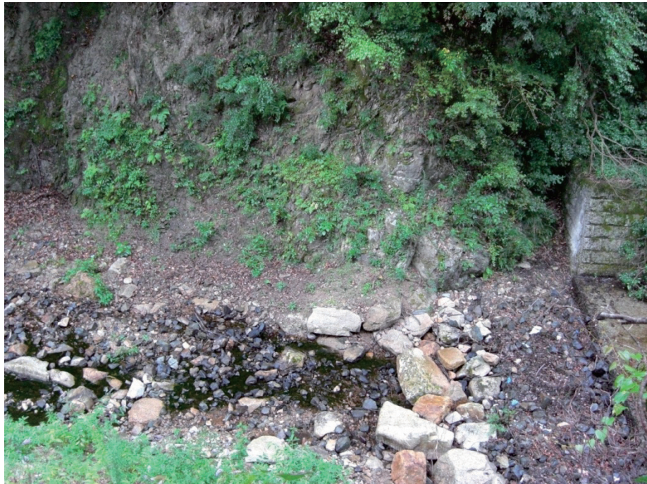
(5) 事故発生場所：崖端より崖下を見る（約10mの高低差）
