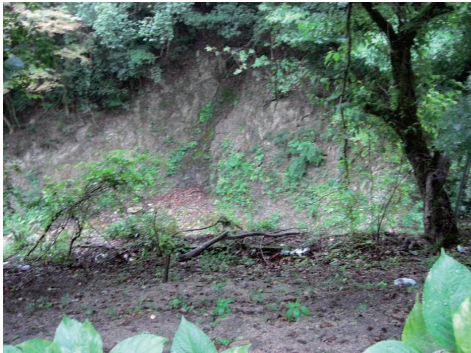
(3) 事故発生場所：縁石への衝突点付近から崖下方向を見る
