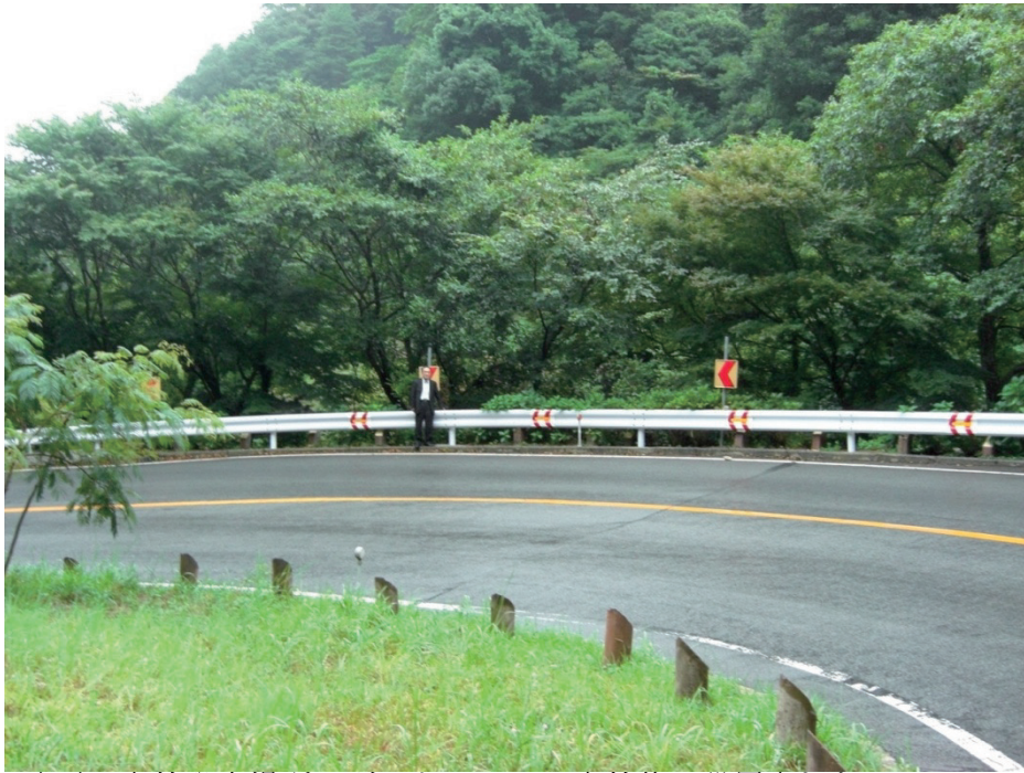
(1) 事故発生場所：ガードレールは事故後に設置された
